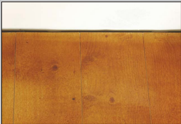
Abb. 17 Lackschicht eines mit Schellack präparierten Holzfußbodens.
