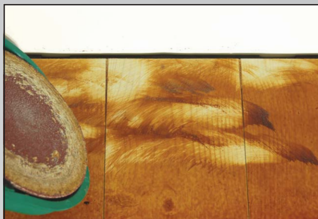
Abb. 18 „Schmier“ verursacht durch falsch gewähltes Schleifmittel.
