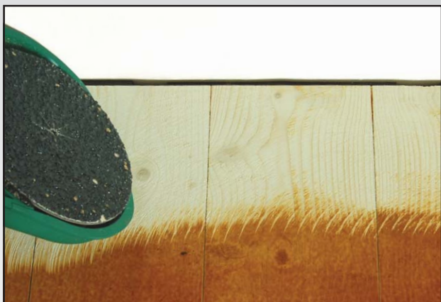
Abb. 19 Eine dicke alte Lackschicht wird vorzugsweise mit den Körnungen 16 oder 24 entfernt.
