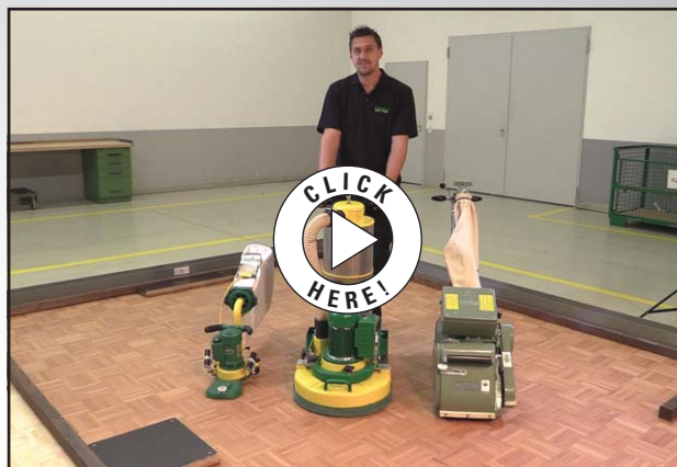
Abb. 9 Bearbeiten des Buche-Fußbodens.
