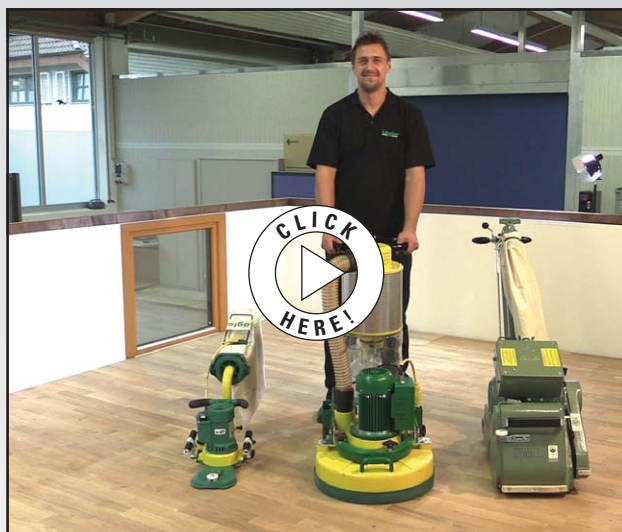
Abb. 8 Bearbeiten des Eiche-Fußbodens.
