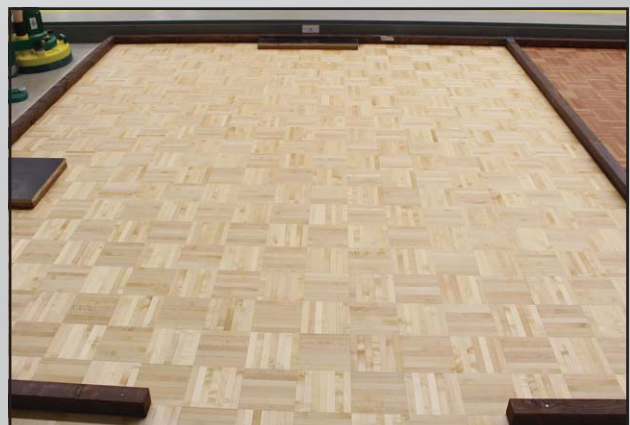
Abb. 6 Ahorn-Fläche vor der Renovierung.
