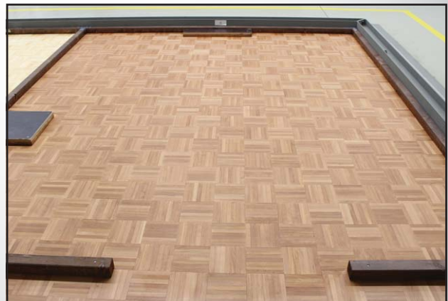
Abb. 5 Buche-Fläche vor der Renovierung.
