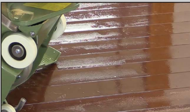
Abb. 3 Gut erkennbar: Starke Schüsselung der Dielen.
