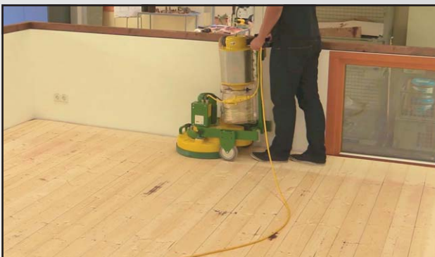
Abb. 12 Entfernen der Frässpuren mit der TRIO.
