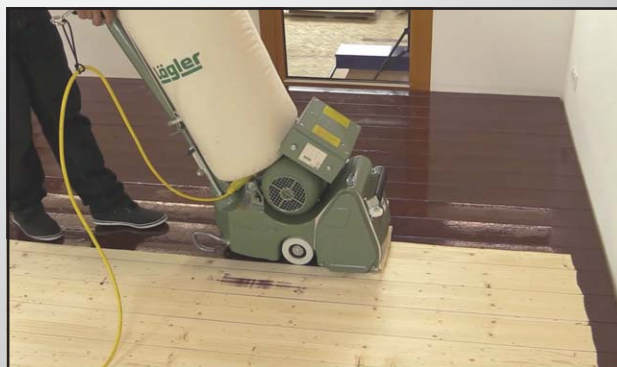
Abb. 7 Fräsen der Fläche.
