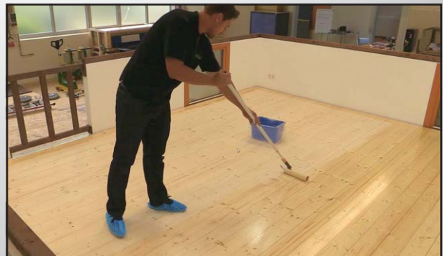
Abb. 15 Aufwalzen des Öls.
