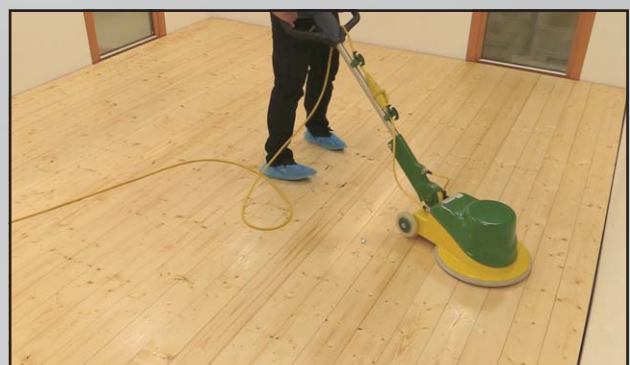
Abb. 16 Einpadden mit der SINGLE.
