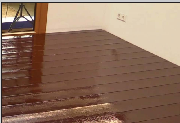
Abb. 17 Geschüsselte, lackierte Fläche vor der Bearbeitung.
