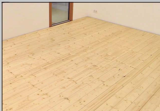
Abb. 18 Fertig bearbeitete, geölte Fläche.
