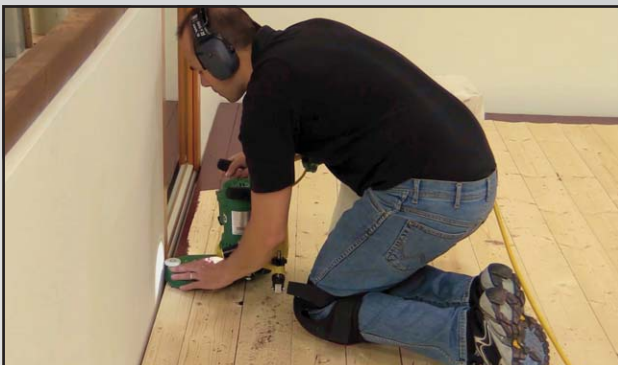
Abb. 11 Schleifen des Randbereichs mit Körnung 24.
