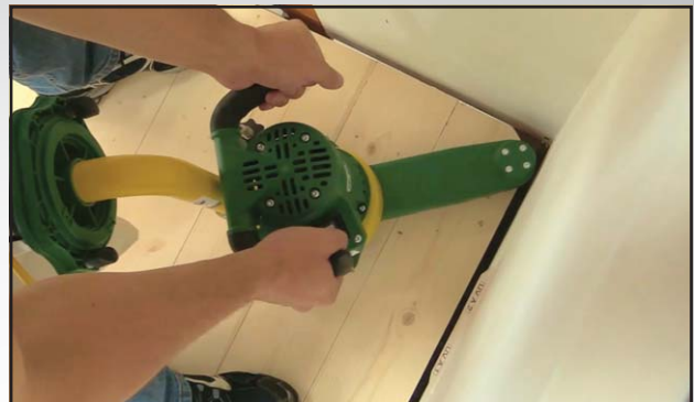
Abb. 13 Schleifen mit dem Eckenvorsatz.
