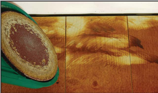
Abb. 2 Schleifen einer dicken Lackschicht im Randbereich mit ungeeignetem Schleifmittel.
