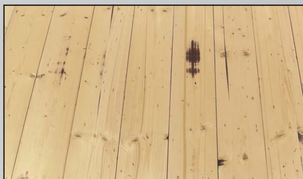
Abb. 8 Nach dem Fräsen abgesaugte Fläche.
