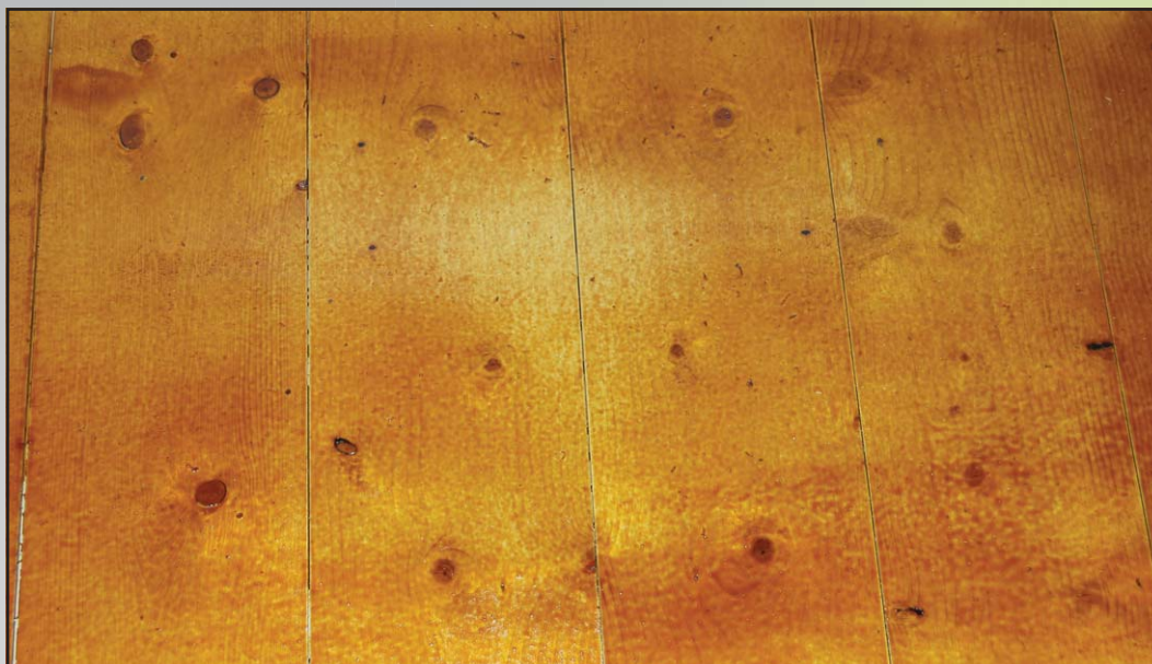
Abb. 1 Dicke Lackschicht auf einem Dielenboden.
