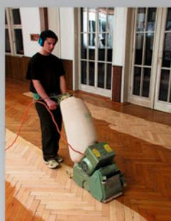
Bei der Sanierung setzte Erb auf die Stärken des Lägler-Programms. So wurde mit der HUMMEL (Körnung 36/60/100) der Grundschliff durchgeführt, UNICO und RANDMEISTER kamen mit einer Körnung
