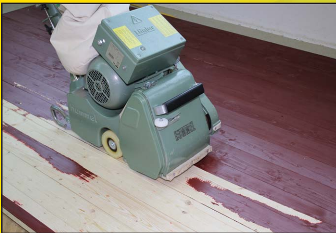
Abb. 3 Dielenboden beim Fräsen mit der IGEL
