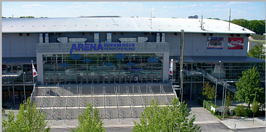
Foto: ARENA Nürnberg Betriebs GmbH
