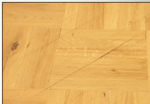
Abb. 5 Einschleiff einer Kante, verursacht durch eine zylindrische Schleifwalze
