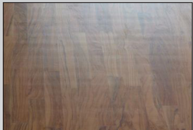
Abb. 3 Wellenschlag verursacht durch eine wieder aufbereitete Schleifwalze
